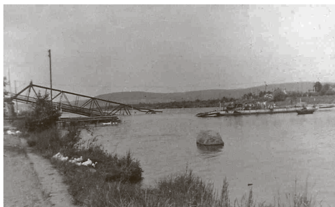
Die eingestürzte Mainbrücke.
