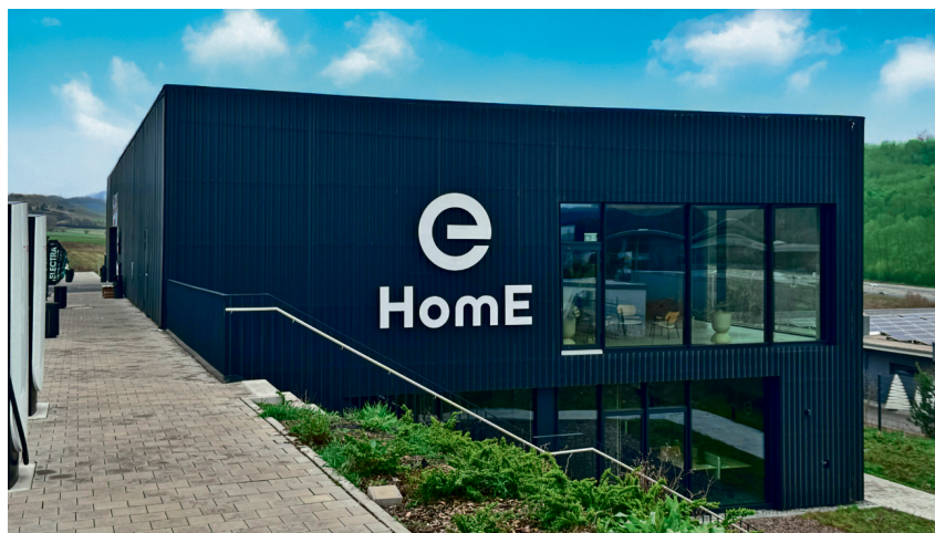
Hauptsitz der Home of Mobility GmbH in Wertheim, Am Fuchsenacker 2, und neuer VW Pop-Up-Store vom Autohaus Adam Wolfert. Foto: Dan Christopher Klein
