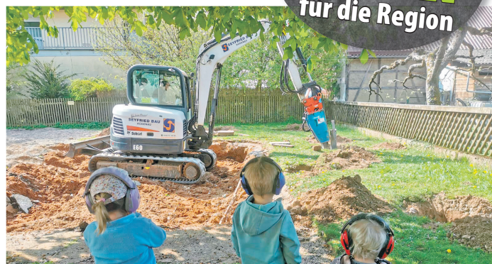
Das Foto entstand bei einem unserer Arbeitseinsätze – an dem Tag, als zum ersten Mal der Bagger auf den Spielplatz kam und unsere Kinder ganz begeistert zugeschaut haben.
