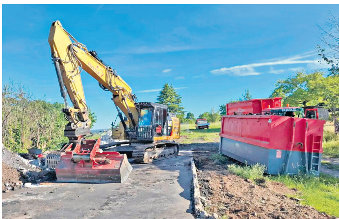
Abriss der ehemaligen Lagerhalle am Rainweg.
