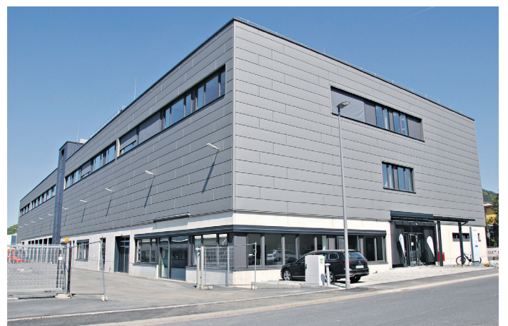
Das neue Technikgebäude der Fripa Papierfabrik Albert Friedrich KG in der Siemensstraße in Miltenberg. Foto: Andrea Kaller-Fichtmüller
