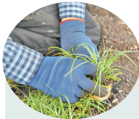
Grün aufs Dach: Die Bepflanzung schafft neue Lebensräume für Tiere und Pflanzen und verbessert gleichzeitig das urbane Mikroklima.
