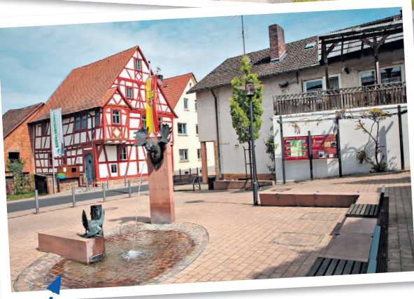
Ortsmitte Eschau: saniertes Historisches Rathaus.
