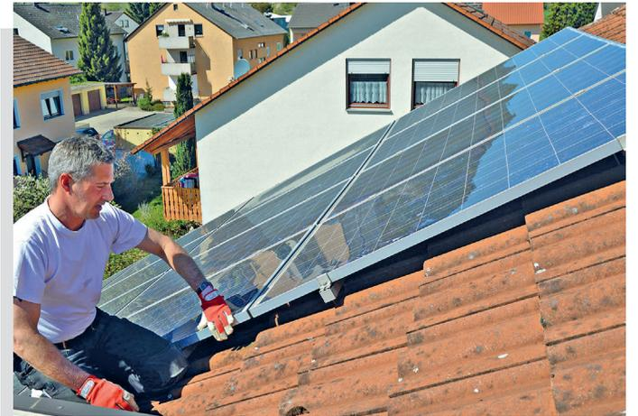
Der qualifizierte Dachdecker prüft die Befestigungen der Solarmodule und begutachtet die Unterkonstruktion im Rahmen des DachChecks.
