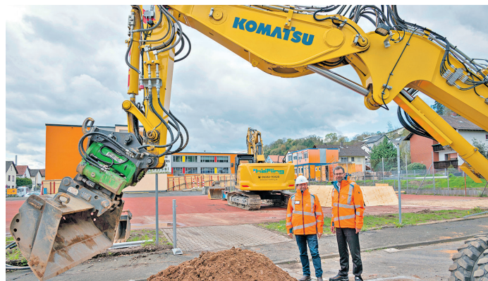
Landrat Jens Marco Scherf (rechts) und Kreisbaumeister Andreas Wosnik informierten sich vom Beginn der Bauarbeiten für eine neue Zweifachsporthalle. Foto: Winfried Zang
