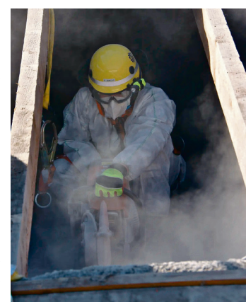
Schwierig gestaltete sich die Schaffung eines Deckendurchbruchs.
