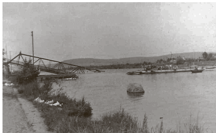
Die eingestürzte Mainbrücke.
