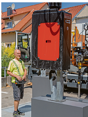
Erster Schritt bei der Leerung der Unterflur-Container: Roland Grundmann hakt den Sammelbehälter ein. Foto: Winfried Zang
