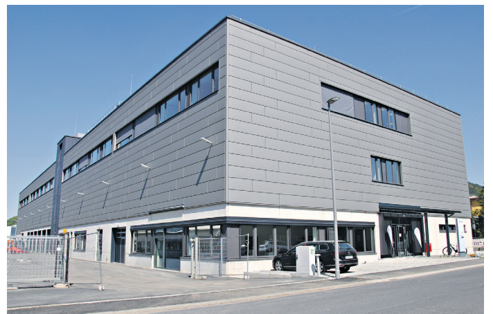
Das neue Technikgebäude der Fripa Papierfabrik Albert Friedrich KG in der Siemensstraße in Miltenberg. Foto: Andrea Kaller-Fichtmüller
