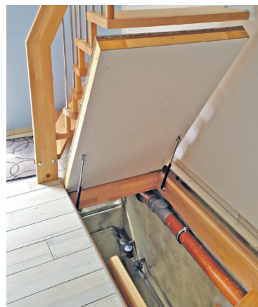
Wenn in älteren Häusern die Kellertreppe direkt an eine Tür stößt, die sich in den Flur oder Wohnbereich öffnet, ist eine Bodenluke eine gute Alternative. Foto: Treppenmeister
