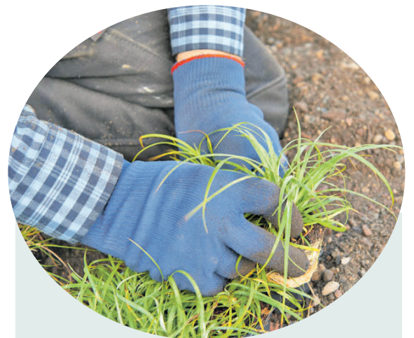
Grün aufs Dach: Die Bepflanzung schafft neue Lebensräume für Tiere und Pflanzen und verbessert gleichzeitig das urbane Mikroklima.
