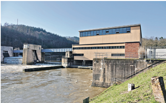
Drei Wehrfelder der Staustufe Freudenberg werden ab 2028 umfassend saniert: Die Vorbereitungen laufen schon.
