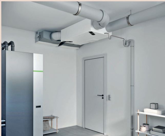
Die zentralen x-well Lüftungsgeräte werden in der Regel im Keller oder Technikraum installiert. Sie sind in verschiedenen Leistungsstufen erhältlich und mit hocheffizienten Außenluftfiltern ausgestattet. Foto: Kermi GmbH/akz-o
