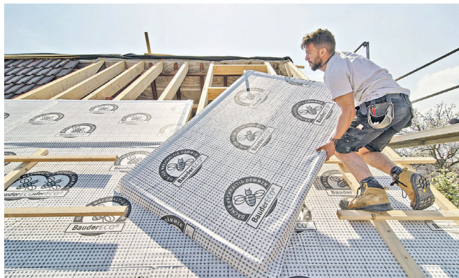
Energie sparen und das Raumklima verbessern: Eine nachträgliche Dämmung des Dachs trägt in älteren Gebäuden wesentlich zu mehr Energieeffizienz bei.
