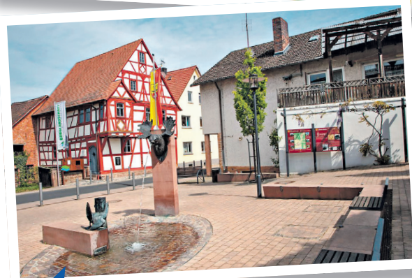
Ortsmitte Eschau: saniertes Historisches Rathaus.
