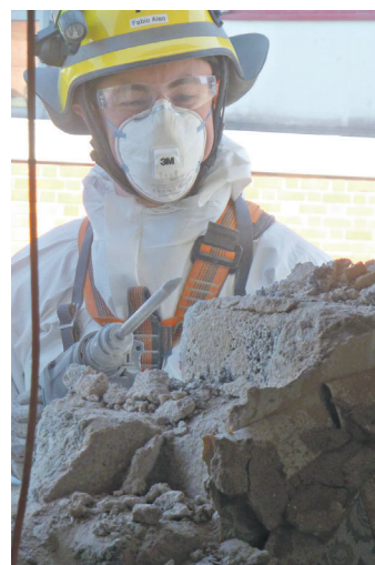
Ein Wanddurchbruch wird hergestellt. Foto: THW-Miltenberg
