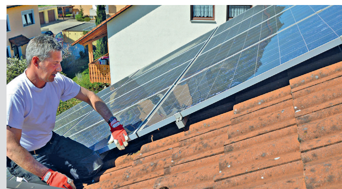
Der qualifizierte Dachdecker prüft die Befestigungen der Solarmodule und begutachtet die Unterkonstruktion im Rahmen des DachChecks.
