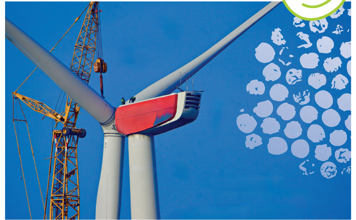
Wartungsarbeiten an der Gondel: Ein Arbeitsplatz, der absolute Schwindelfreiheit voraussetzt.
